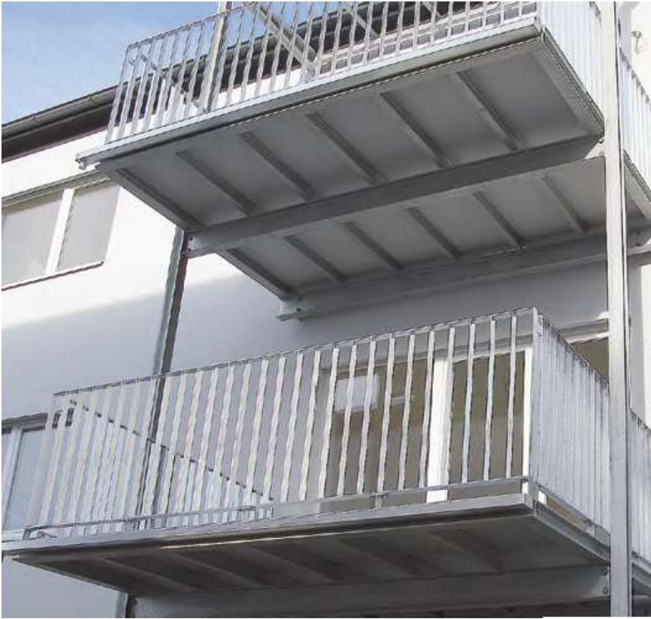
PANNELLO PAVIMENTO BALCONI EDIFICIO ST. VEIT/GLAN, AUSTRIA
