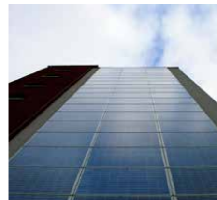
Pannelli solari integrati nella facciata.
